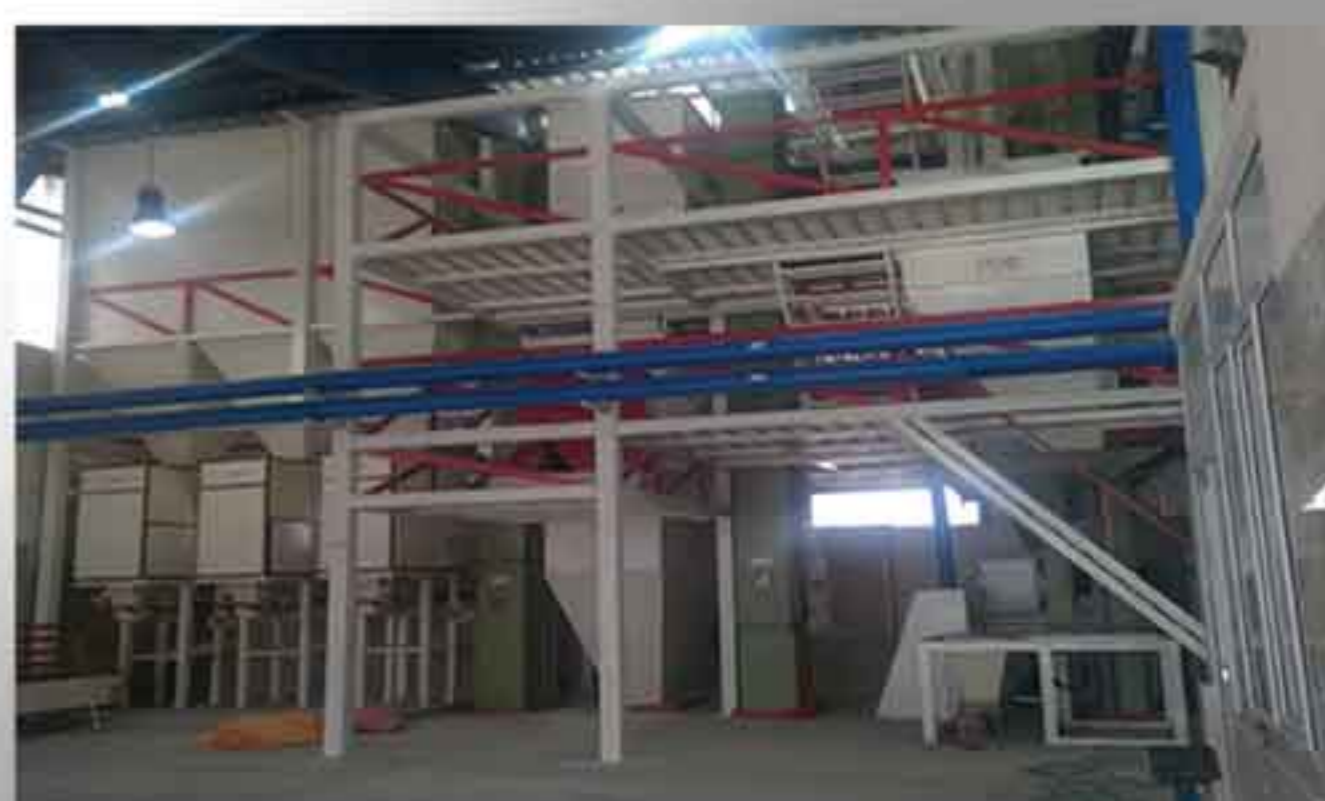
شرکت انبار دان مرکزی نوید-فاز ۲ تاریخ احداث پروژه : سال ۹۵ محل احداث : رشت
