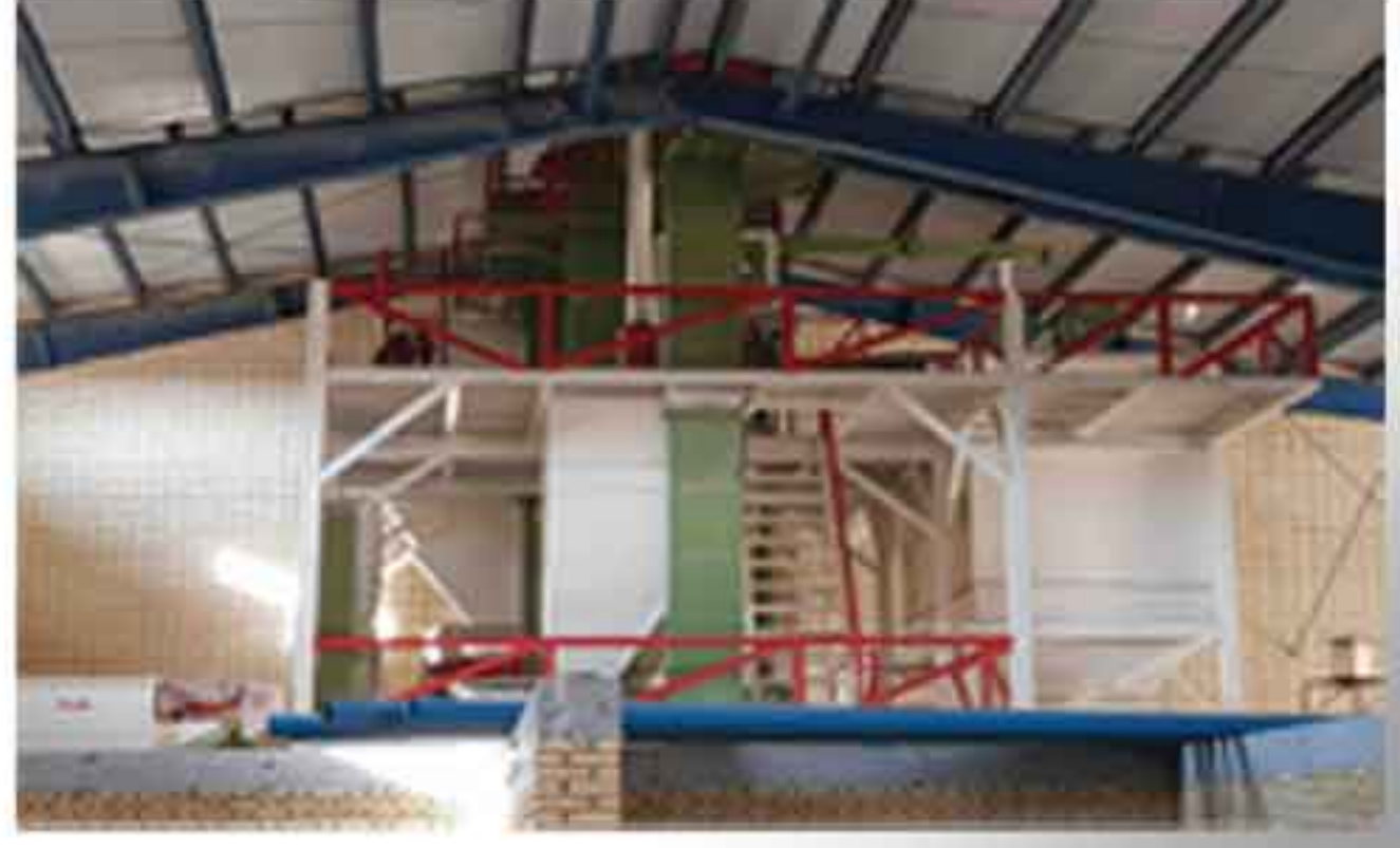
واحد تولید خوراک آرین دان دشتستان تاریخ احداث پروژه : سال ۹۶ محل احداث : برازجان
